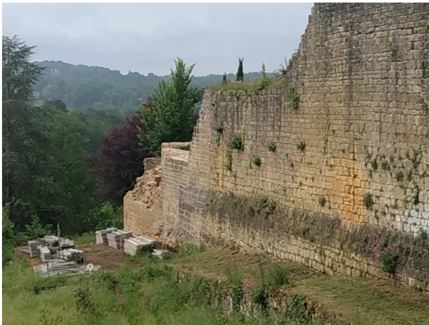
Rénovation et restauration du rempart au sud de la Porte des Tours ( premier trimestre 2022)
