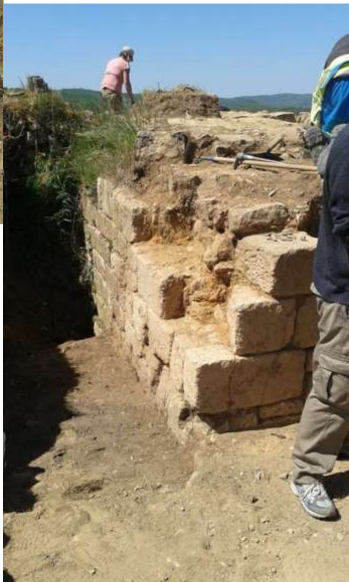
Façade sud-est du donjon – mardi 18 avril 2017
