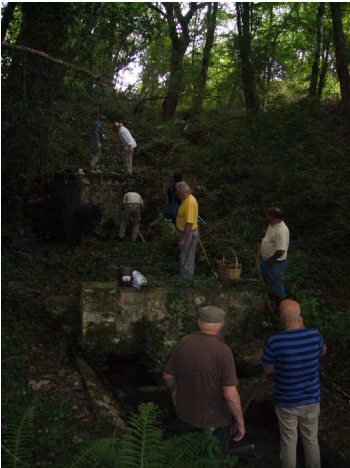
Nettoyage de la source par les bénévoles de l'ASBDR. On distingue, à l'arrière plan le réservoir de captage d'où part la conduite forcée vers Domme.
